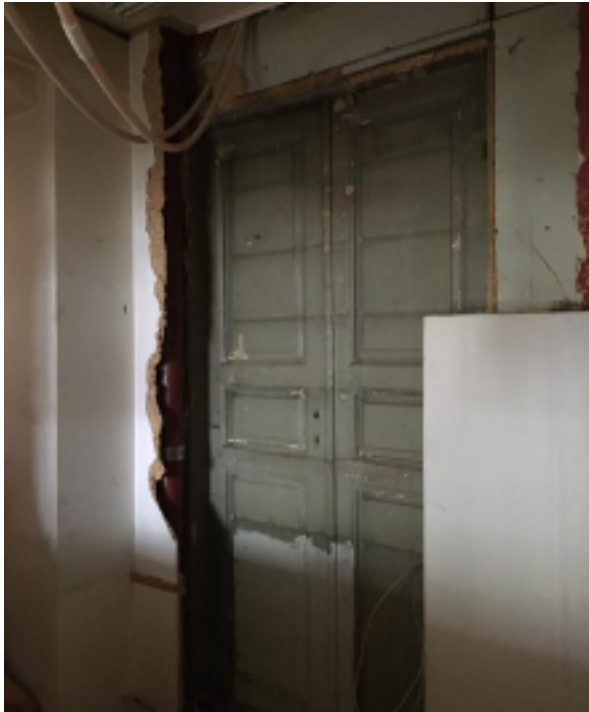
Kuva 12: Esiinkaivettu pariovi baarin ja ns. emännän huoneen välisellä seinällä. Empiretyylinen pariovi on maalattu tummansiniharmaalla maalilla.
