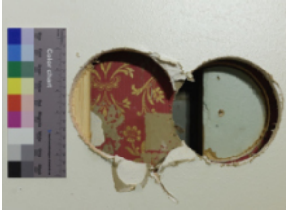
Kuva 11: Rasiaporalla poratut näytekohdat keittiössä, ns. emännän huoneen ja baarin väliseltä seinältä.
