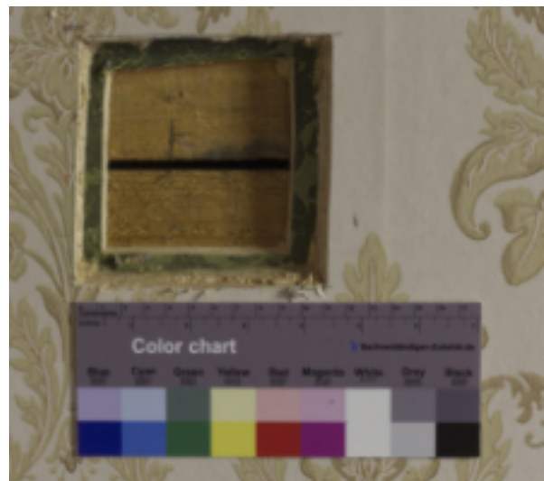
Kuva 7: Marski-kabinetin luoteisseinän esiinotto peitetyn ikkunan kohdalta.
